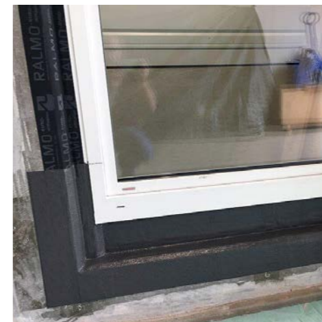
Abbildung 13b) Bodeneinstandsprofil mit Andichtkeil und Flüssigabdichtung
