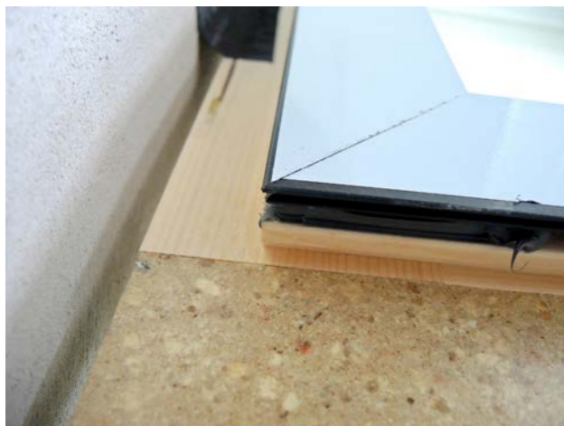
Abbildung 12a) Flächenbündiger Übergang vom Bodeneinstandsprofil zum Stockprofil
