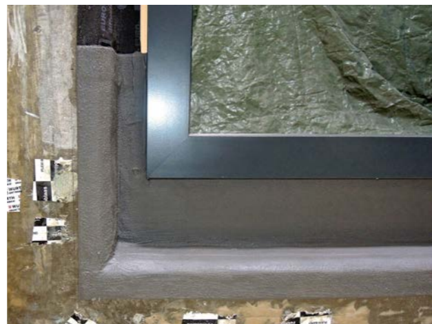
Abbildung 12b) Flächenbündiger Anschluss der Abdichtung
