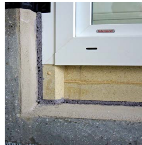
Abbildung 13a) Bodeneinstandsprofil mit Andichtkeil (bei Alu-Halbschale)
